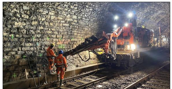
**Eignungsprüfung (Ankerzugversuch) bei Opfernägel**
