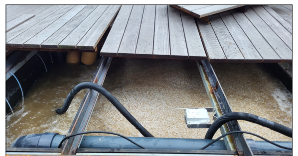
Filter mit Granulat in mittlerer und rechter Kammer und Glukose-Dosierung sowie Absaugkammer in linker Kammer Eigene Darstellung
