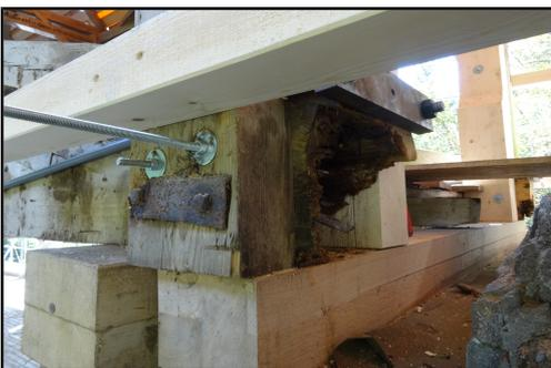
Schadhafter und instand gesetzter Streckbalken
