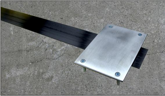
Ausbildung der Endverankerung: Die Lamelle wird zwischen Betonuntergrund und einer Stahlplatte eingeklemmt und verklebt.
