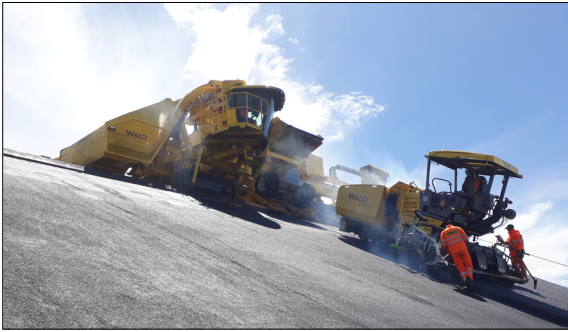
Der neue Fertigerwindenwagen im Einsatz Eigene Darstellung
