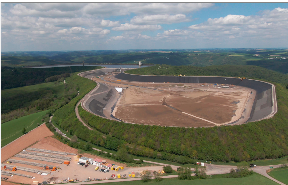
Die gigantischen Dimensionen des Speicherbeckens mit dem Installationsplatz im Vordergrund S. Vogel - im Auftrag der HSR
