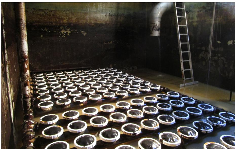
Abbildung 3: Reaktor entleert mit sichtbaren Belüftungselementen
