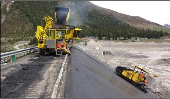
Die Asphaltierung bei einer Steigung von 62 Prozent kann nur durch Spezialmaschinen ausgeführt werden.
