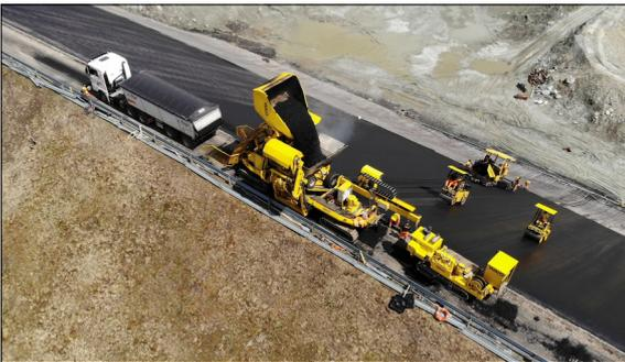
Die Sicherung der Maschinen in der Böschung und die Beschickung des Asphalts passiert von der Dammkrone aus.
