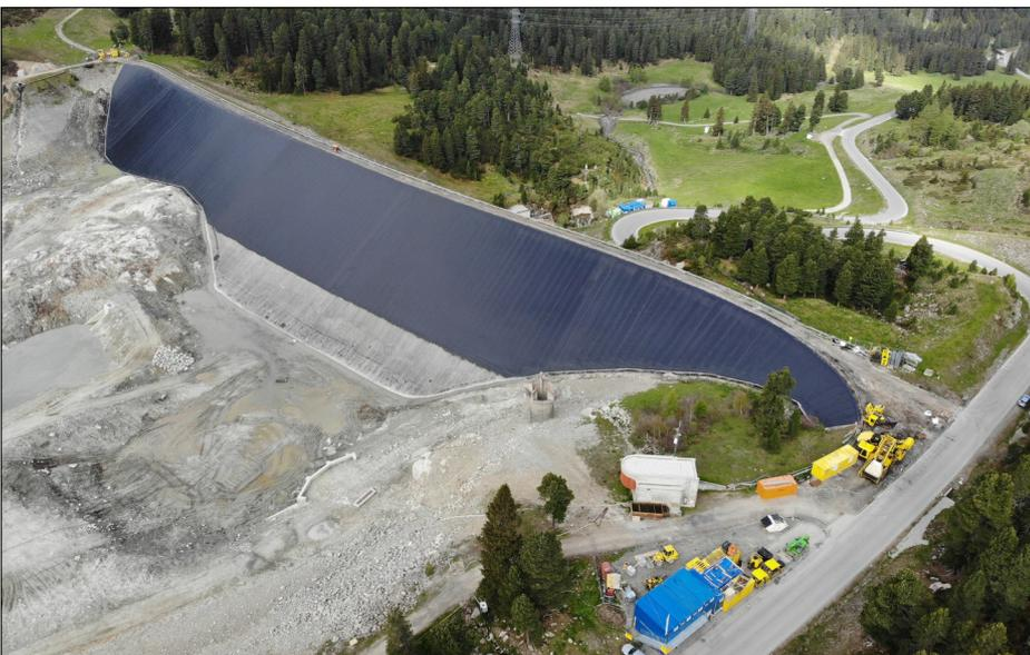
Die fertiggestellte Oberflächenabdichtung des Staudamms Längental inkl. den vorhandenen Baustelleneinrichtungsf lächen.
