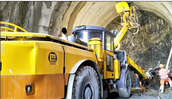
Einsatz des zweiarmigen Bohrjumbos im Sprengvortrieb.
