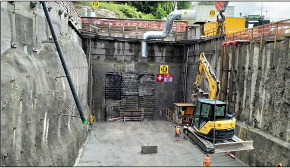
Sämtliche Maschinen müssen aufwendig mittels Pneuroman in oder aus der Baugrube gehoben werden.
