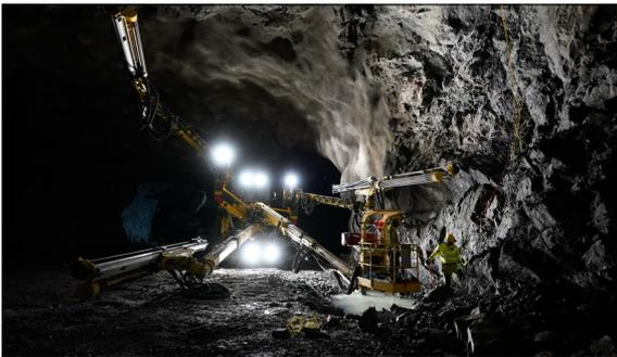
Laden mit Emulsionssprengstoff einer Nachsprengung im Licht des dreiarmligen Bohrjumbos
